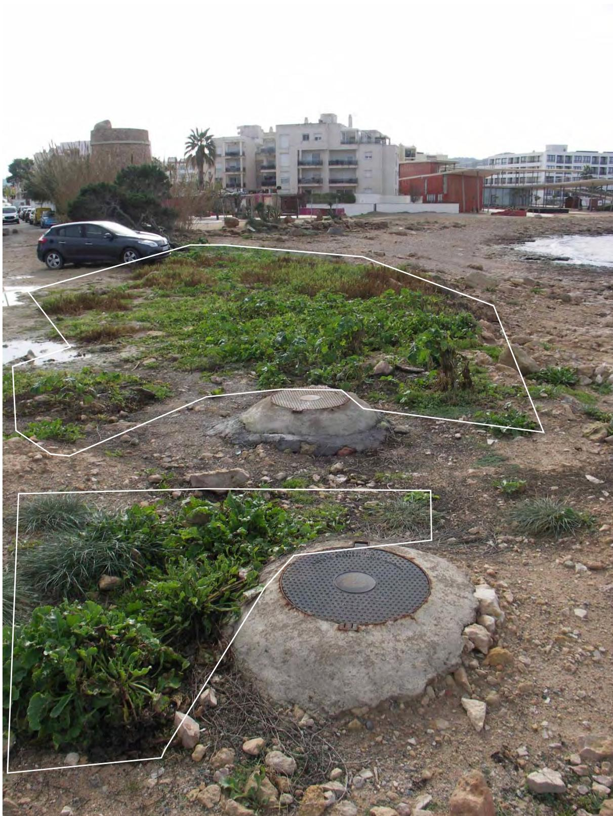
Foto 27. Registros del alcantarillado municipal en el entorno de es Calò de s'Oli. Se aprecia la abundante vegetación nitrófila alrededor de estos registros, indicio de los frecuentes rebosamientos de aguas fecales mezcladas con pluviales, que tienen lugar en esta zona durante los episodios de lluvias torrenciales.
